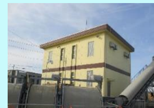
排水機場の耐震対策・更新整備
