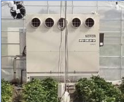
実証開発機：暖房熱量28.0kW
