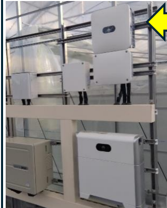
蓄電池とパワーコンディショナ (直流→交流に変換し動力源に)
