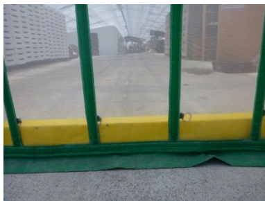
動物等の侵入防止対策の例
