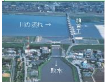
河川からの取水施設 （頭首工）
