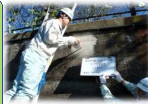
用水路の機能診断
