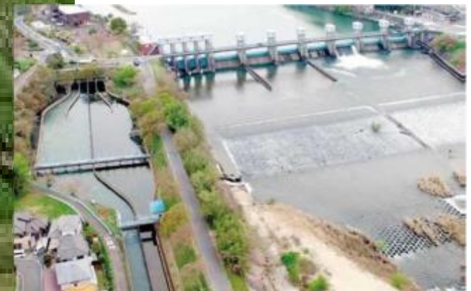
明治用水頭首工
