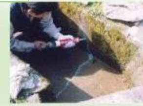
水路のひび割れ補修
