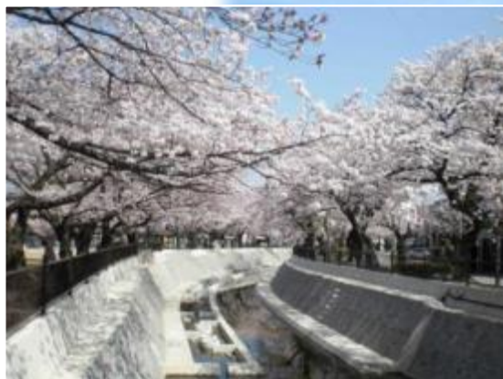
整備された大江排水路(環境配慮)
