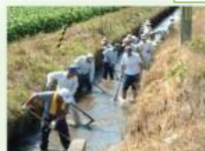
水路の泥上げ
