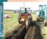
暗渠排水の 設置
