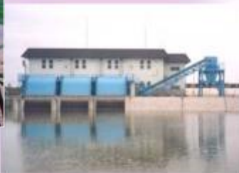
排水機場の整備
