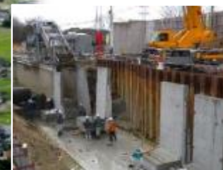
水路改修工事状況
