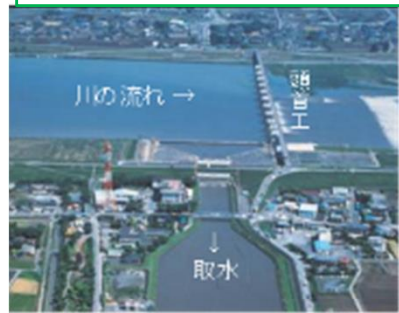
河川からの取水施設 （頭首工）
