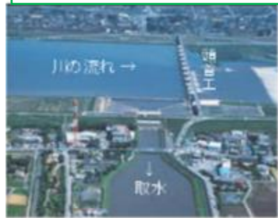
河川からの取水施設 （頭首工）
