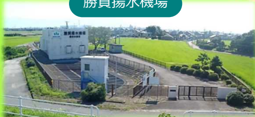
勝賀揚水機場
