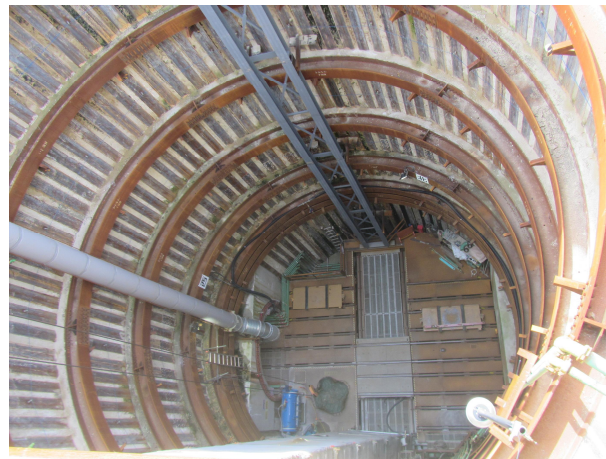
シールド工事（発進立坑）
