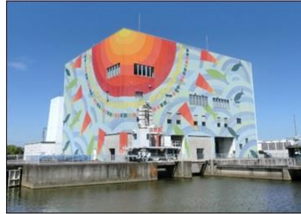
尾西排水機場
