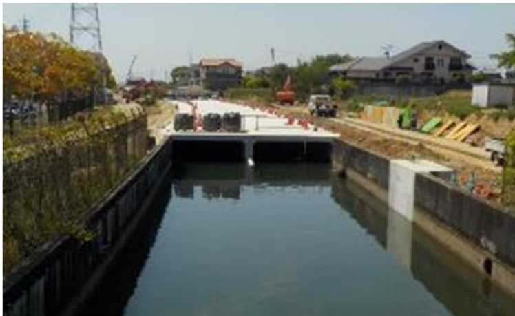
幹線用水路の耐震化工事
