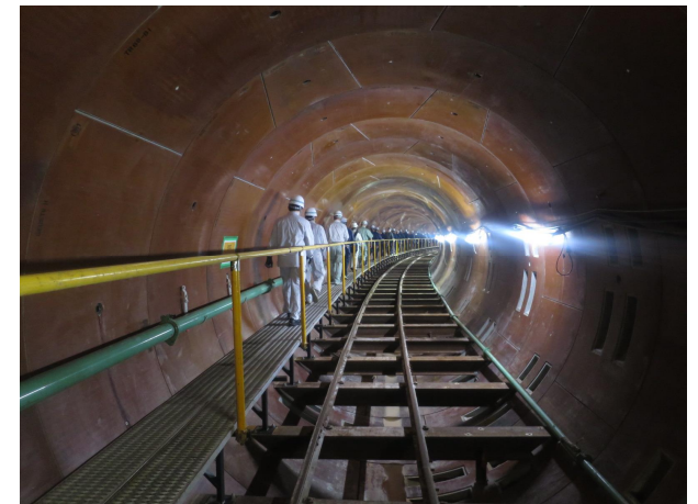
シールド工事（トンネル内部）
