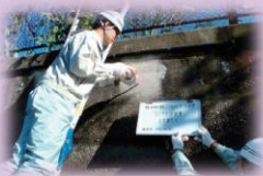
用水路の機能診断
