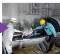
工事の監督・検査
