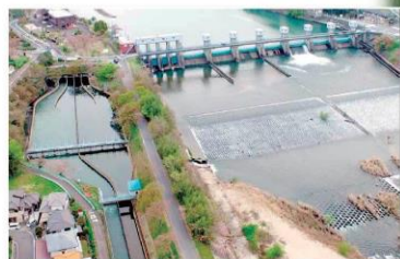
▲明治用水頭首工
