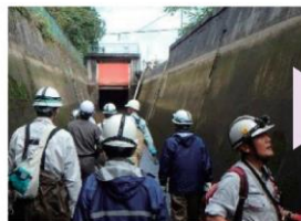
施設の機能診断
