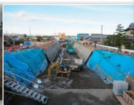
▲水路工事状況
