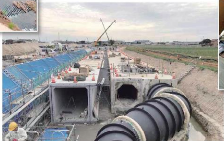
用水路の改修状況▶
