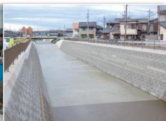
▲整備された水路
