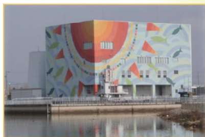
▲尾西排水機場
