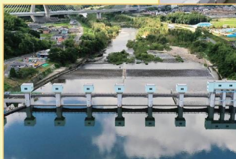
▲明治用水頭首工
