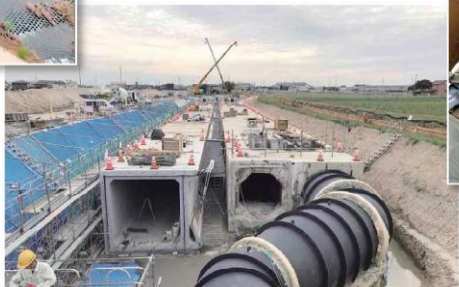
用水路の改修状況▶
