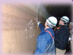
用水路の機能診断
