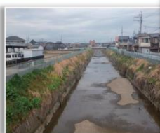
▲整備前の水路
