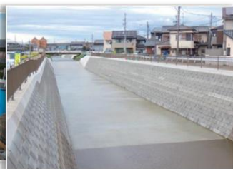
▲整備された水路
