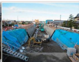
▲水路工事状況
