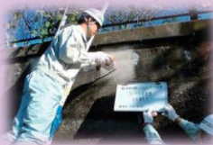
用水路の機能診断
