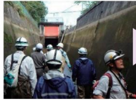
施設の機能診断
