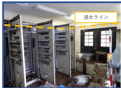
豪雨により被災した農業集落排水処理施設（R5年6月）
