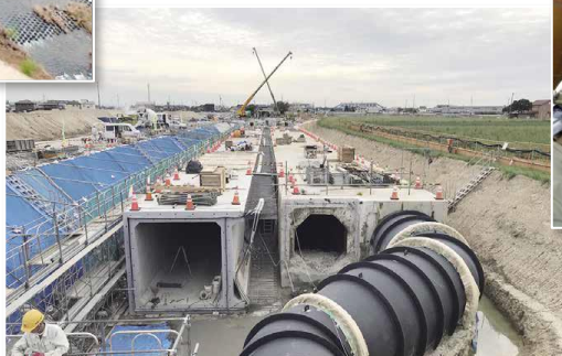
用水路の改修状況▶
