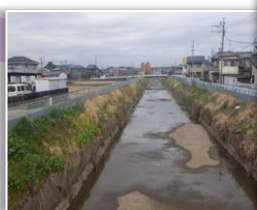
▲整備前の水路
