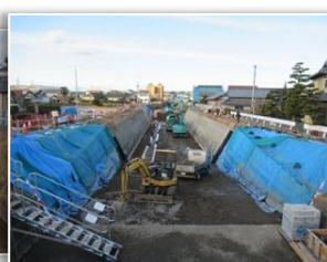
▲水路工事状況
