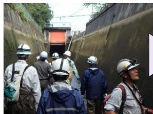
施設の機能診断
