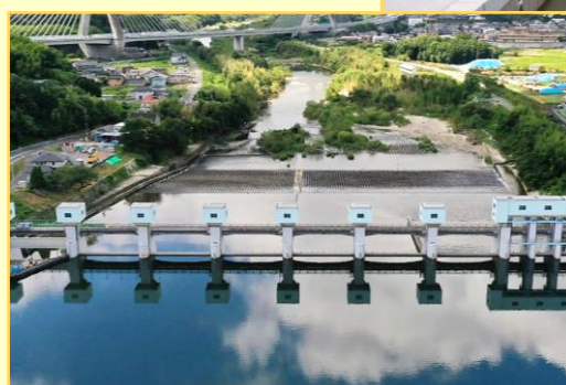
▲明治用水頭首工
