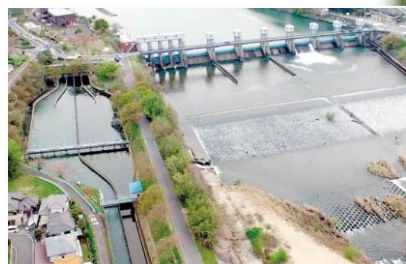
▲明治用水頭首工
