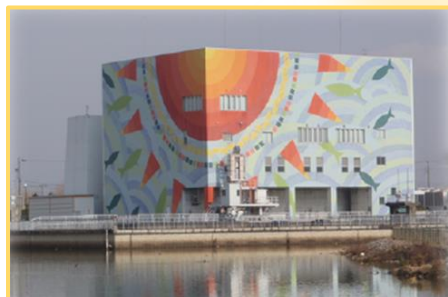
▲尾西排水機場
