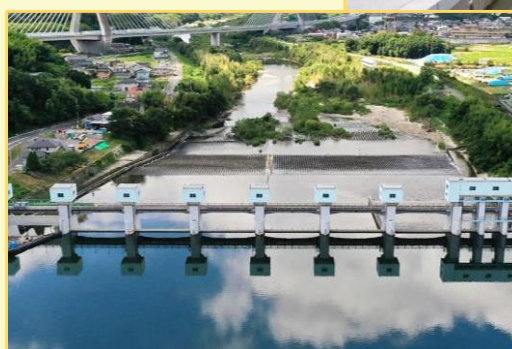
▲明治用水頭首工
