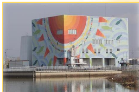
▲尾西排水機場
