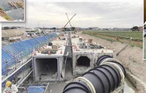
用水路の改修状況▶
