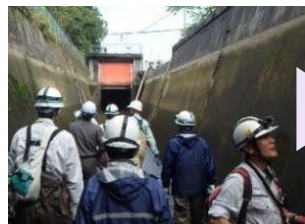
施設の機能診断
