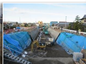
▲水路工事状況
