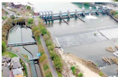
▲明治用水頭首工
