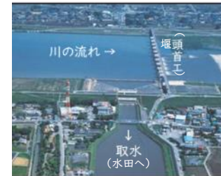
河川からの取水施設 （頭首工）
