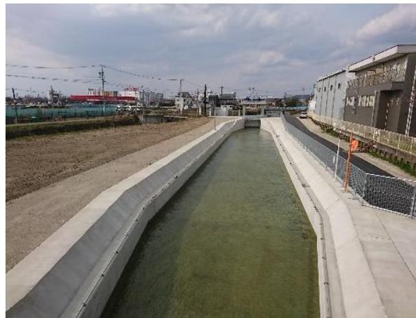
水路周辺の都市化・混住化に伴い家庭雑排水等の流入による水質汚濁及びゴミ投棄による安全・安定通水の障害等が発生し、さらに流域の都市化の進行等による降雨時の流出形態の変化により排水機能が低下しているため、改修工事を実施した事例
